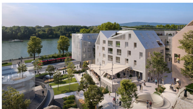
Vydrica, Bratislava, vo výstavbe
